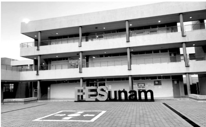
El CLe se encuentra comprometido con la calidad de sus servicios
