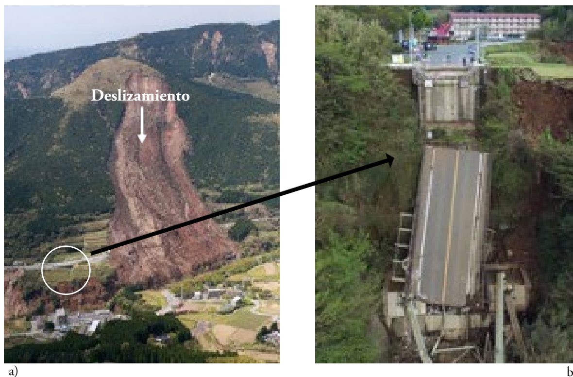
Figura 3. a) Deslizamiento de tierra sobre el puente Aso Ohashi, en Japón. el círculo indica el área del colapso; b) desplome del puente Aso Ohashi. Fuentes: a) elnuevodiario.com (17 de abril de 2016); b) El Diario de Coahuila (17 de abril de 2016).
